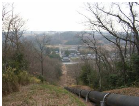
写真 御坂サイホン導水管
