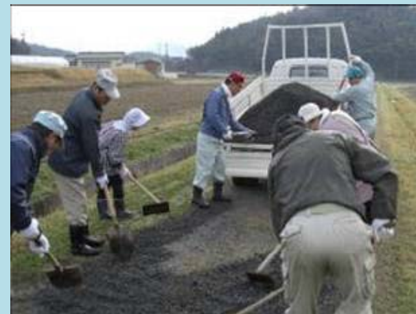
住民による農道の補修(綾部市)
